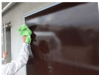
玄関ドア塗装面の保護
