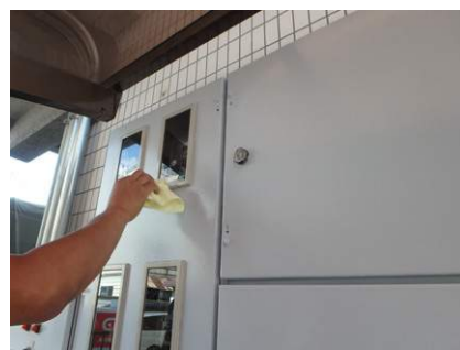
分電盤の塗装面保護
